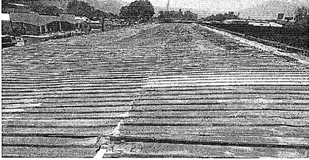
Foto 01: Area de sustitucion de lamina.
