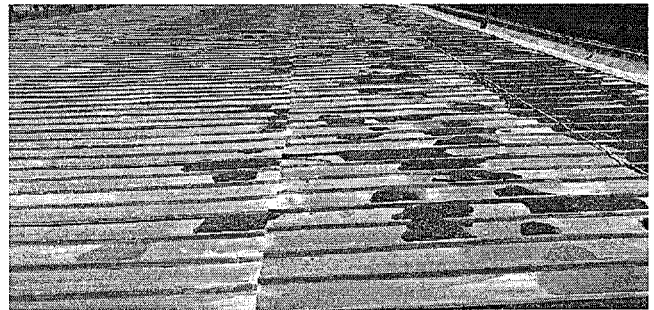
Foto 06: Area de sustitucion de lamina.
