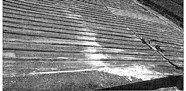
Foto 04: Area de sustitucion de lamina.
